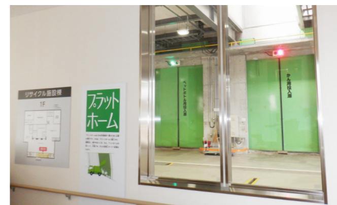
A 見学窓 収集車がごみを搬入するプラットフォームを見学窓から見るができます。
