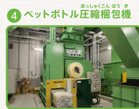
せんべつ ペットボトル せんべつ 選別したペットボトルを機械で押しつぶしてかたまりにします。
